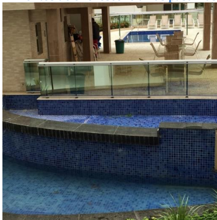
Figura 122. Pontos de eflorescência nas pastilhas e mureta.
