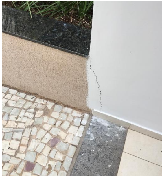
Figura 23.Fissura.
