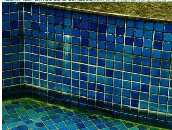
Figura 126. Pontos de eflorescência nas pastilhas e mureta.
