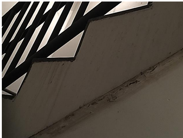
Figura 16. Pintura danificada.
