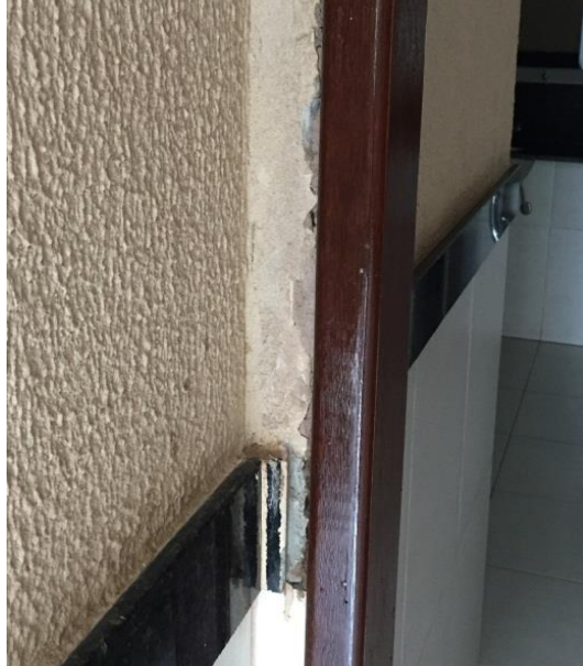
Figura 166. Pintura danificada.
