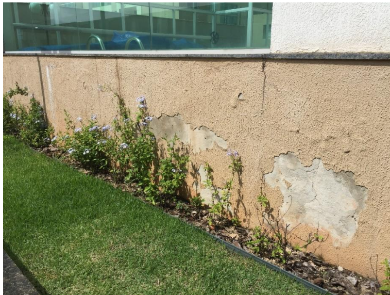
Figura 105. Ausência de rejunte no granito e de reparo na junta da base mureta de jardim.
