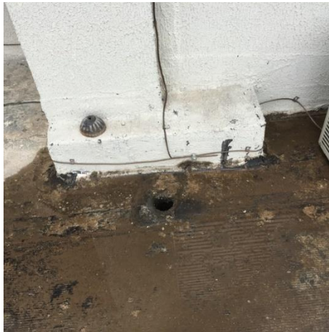
Figura 235. Ralo abacaxi com tampa desencaixada.
