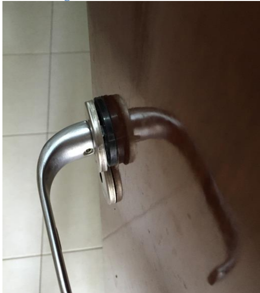
Figura 167. Maçaneta quebrada.
