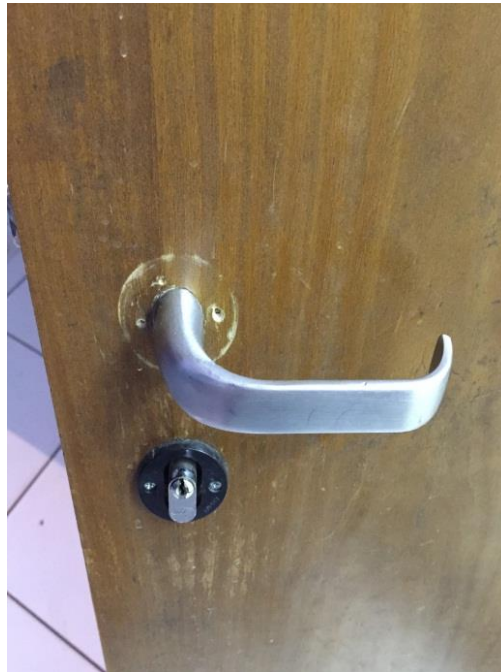
Figura 177. Maçaneta quebrada.
