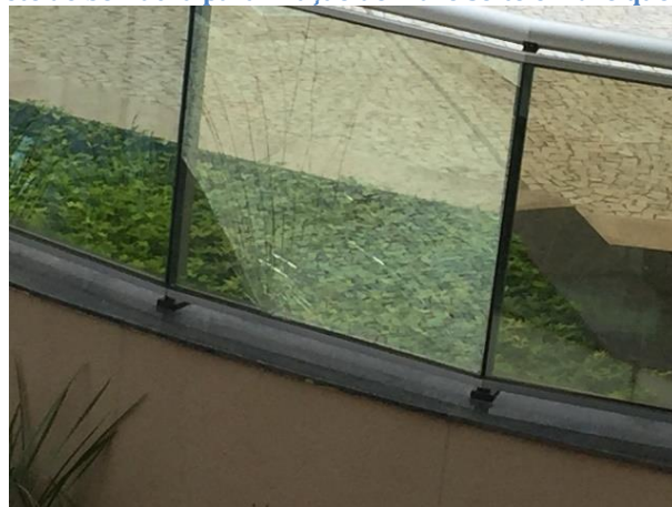
Figura 26. Baguete de borracha para fixação do vidro solto e vidro quebrado na piscina.
