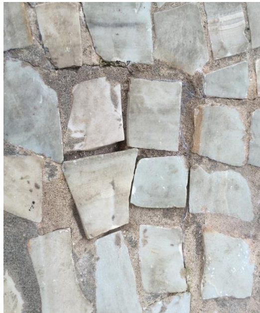
Figura 227. Piso sem rejunte.
