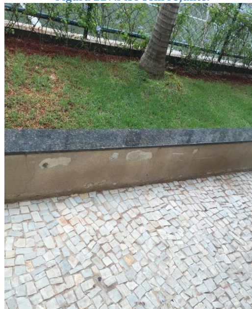
Figura 228. Pintura danificada.
