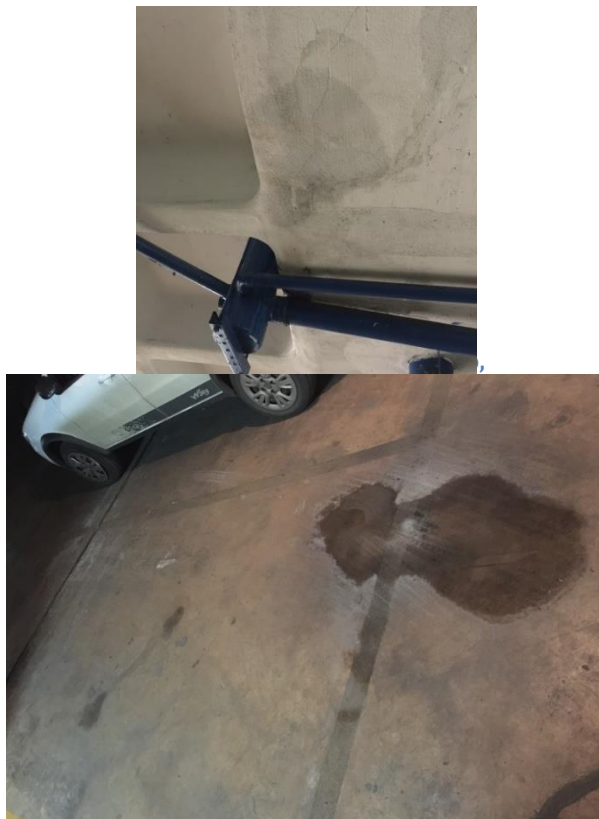
Figura 242.Ponto de infiltração.
