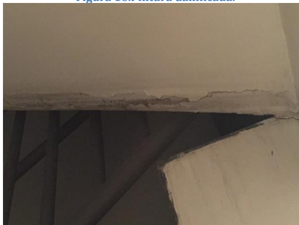
Figura 17. Pintura danificada.
