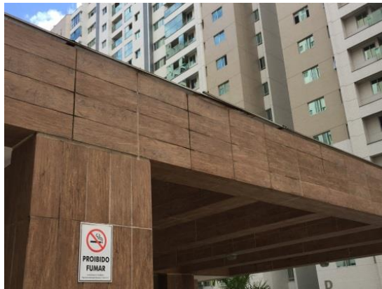
Figura 130..Acabamento de telhado solto.
