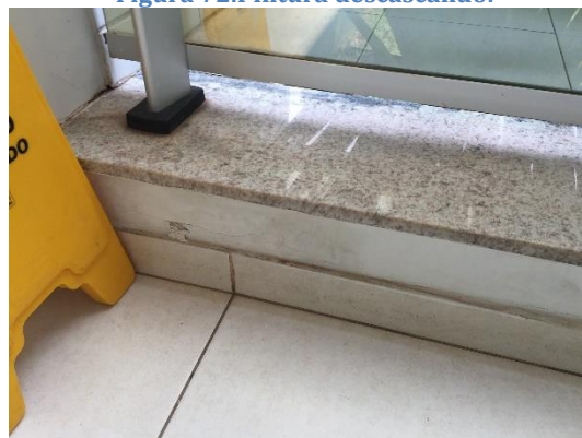
Figura 73. Pintura descascando.
