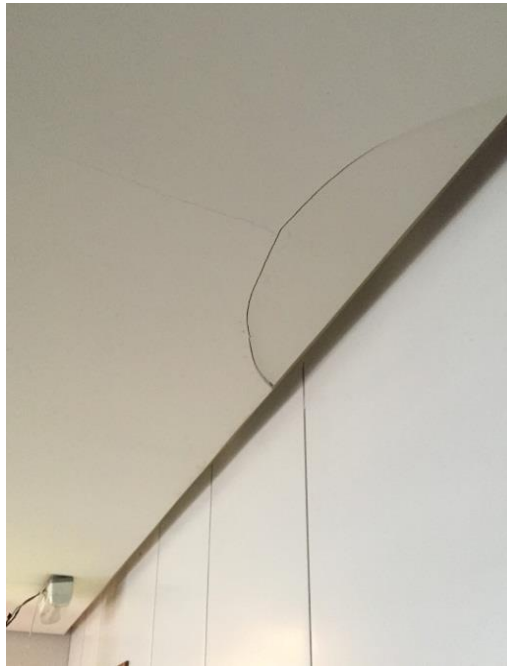
Figura 182. Forro danificado.
