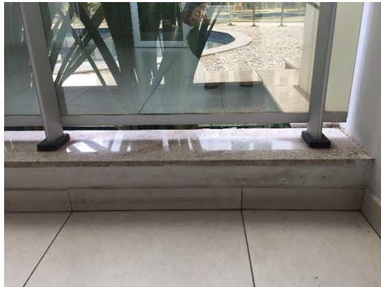
Figura 72. Pintura descascando.
