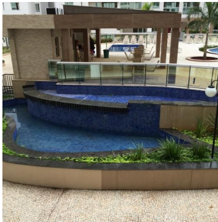
Figura 121. Pontos de eflorescência nas pastilhas e mureta.
