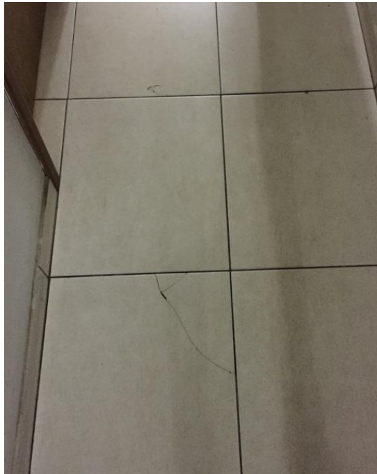
Figura 239. Piso trincado.
