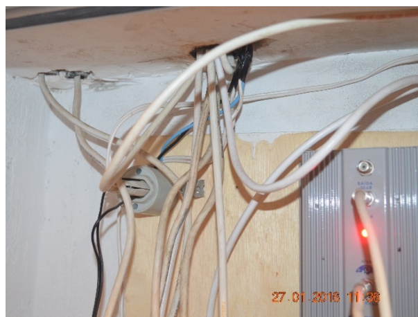
FIGURA 11.CABOS DESORGANIZADOS.
