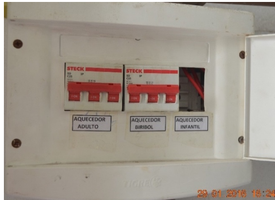
FIGURA 112. AQUECEDOR ADULTO COM INSTALAÇÕES ADULTERADAS.
