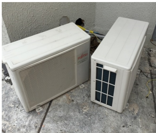
FIGURA 23. INSTALAÇÃO DE AR CONDICIONADO.
