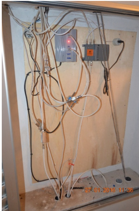
FIGURA 10.CABOS DESORGANIZADOS.
