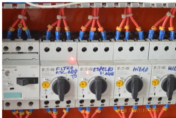
FIGURA 110. CONTADORES COM SOBREAQUECIMENTO.
