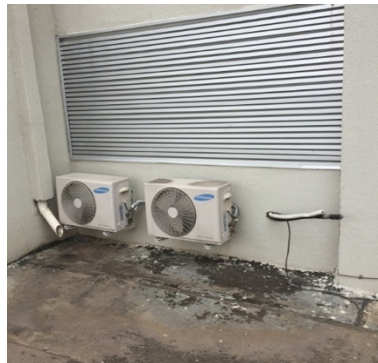
FIGURA 83. INSTALAÇÃO DE APARELHO DE AR CONDICIONADO.
