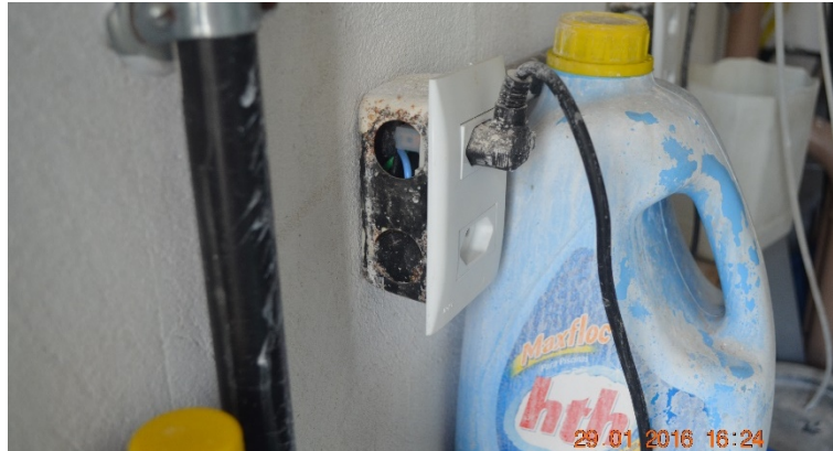
FIGURA 114.FIAÇÃO EXPOSTA.
