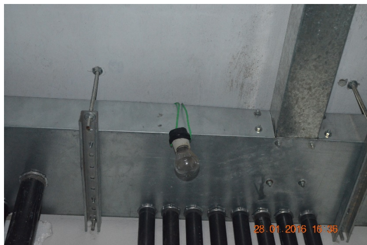
FIGURA 107.FIAÇÃO EXPOSTA.
