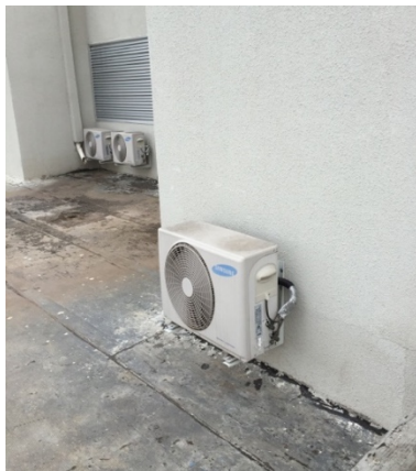
FIGURA 84. INSTALAÇÃO DE APARELHO DE AR CONDICIONADO.
